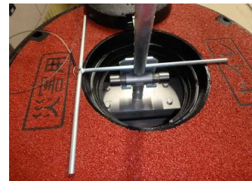
治具の設置状況
